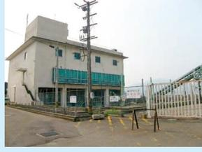
松島ポンプ場は、昭和58年度に供用を開始した雨水排水ポンプ場です。このポンプ場は、異常降雨により増水した二夜の川の水を大型の排水ポンプによって笹の川へ強制的に排水することで、松島地区の浸水被害を防ぐ重要な施設です。
