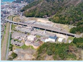
天筒浄化センターは、昭和58年度に供用を開始した下水処理場です。この浄化センターには1日当たり平均約25,000㎡(小学校のプール約80杯分)の汚水が流れてきており、24時間365日休むことなく汚水をきれいにして海に返したり、水処理の過程で発生する汚泥を処理しています。
