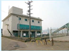
松島ポンプ場は、昭和58年度に供用を開始した雨水排水ポンプ場です。このポンプ場は、異常降雨により増水した二夜の川の水を大型の排水ポンプによって笙の川へ強制的に排水することで、松島地区の浸水被害を防ぐ重要な施設です。
