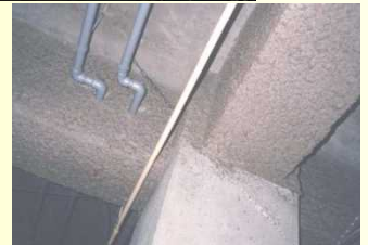
吹付けアスベストの使用例
