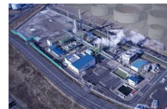
CO2分離・回収・貯留施設
