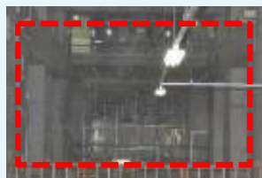
復水器（解体撤去後）
