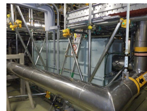
予熱・保温設備（解体前）
