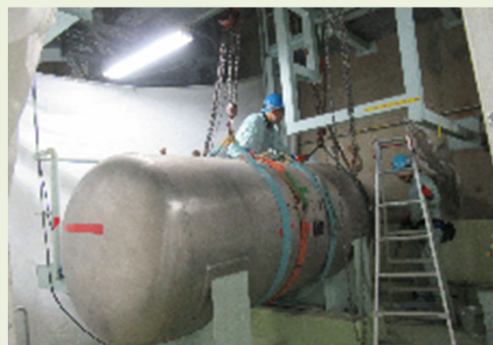
Heサージタンクの解体撤去 （解体中）
