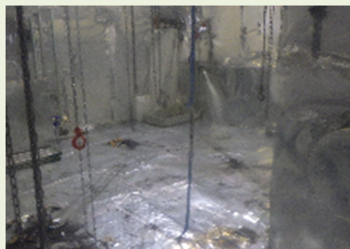
He連通弁廻り（解体後）
