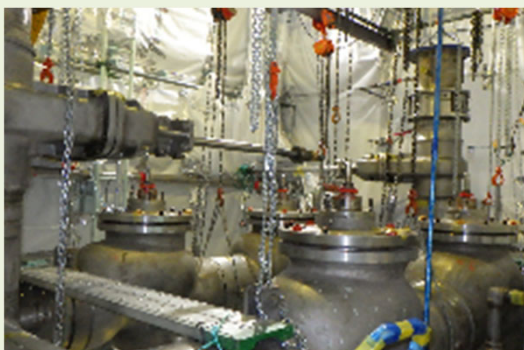
He連通弁廻り（解体前）
