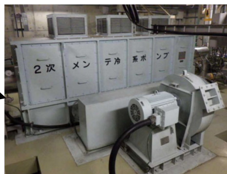
2次メンテナンス冷却系循環ポンプ
