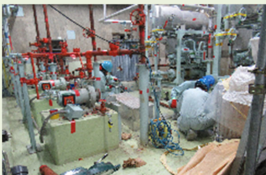
He冷凍装置廻りの解体撤去 （解体中）
