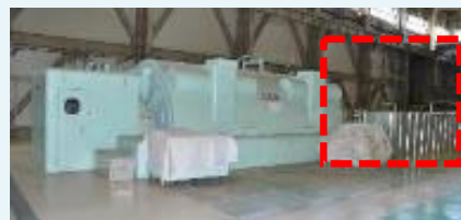
蒸気タービン（解体中※）
