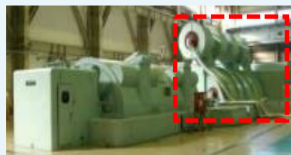
蒸気タービン（解体前）
