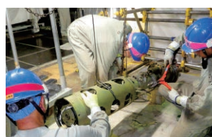
制御棒駆動装置モーター部の分解
