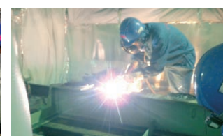
プラズマ溶断作業
