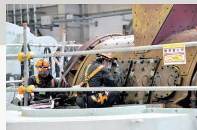
低圧タービン解体中の様子 写真提供：日本原子力研究開発機構
