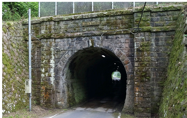
42. ・旧北陸線第一観音寺トンネル
