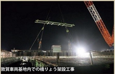
敦賀車両基地内での橋りょう架設工事
