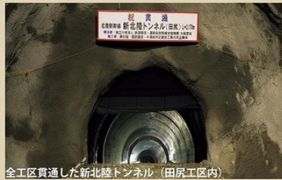
全工区貫通した新北陸トンネル(田原工区内)
