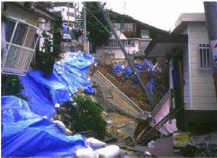
滑動崩落による被害状況（兵庫県南部地震）
