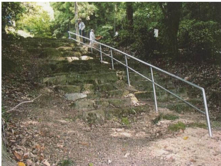
鉄製（ステンレス製）の手すりに変更
