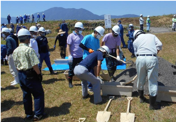
▲プランターを使った浸水防止工法の体験
