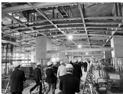
2階コンコースの工事状況
