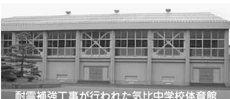
耐震補強工事が行われた気比中学校体育館
