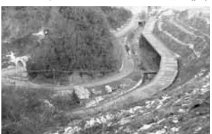
最終処分場対策工事
