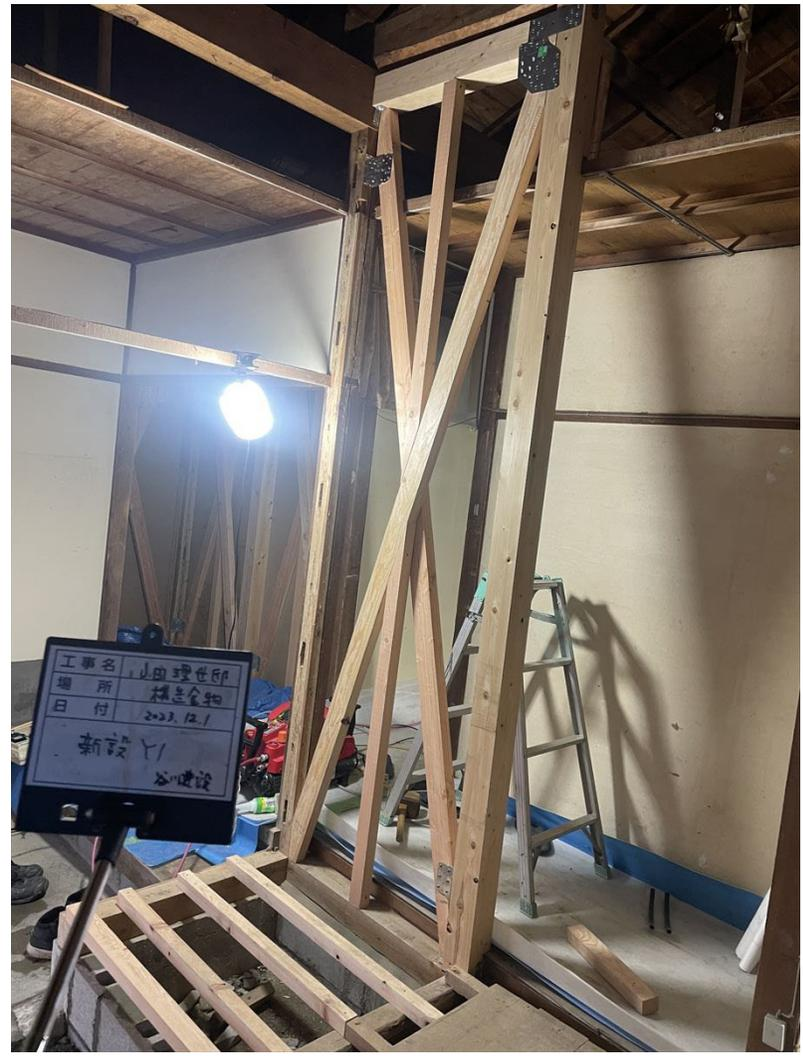
筋交い（すじかい）による耐震補強工事の様子
