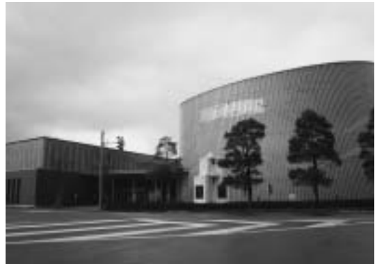
改修されたきらめきみなと館
