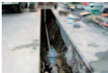
耐震管の布設替え
