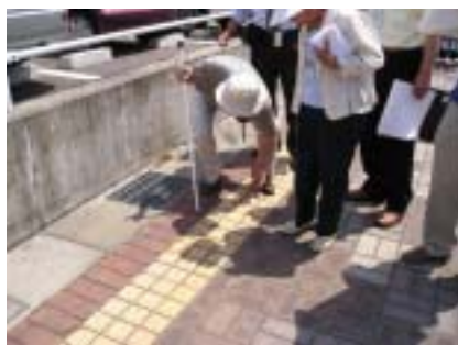
視覚障害者誘導用ブロックの形状 （あいあいプラザ西側）
