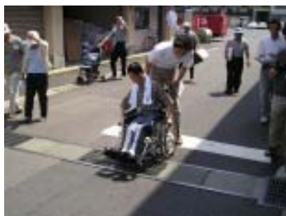
通行部分に設置されたグレーチング （福鉄車庫周辺）
