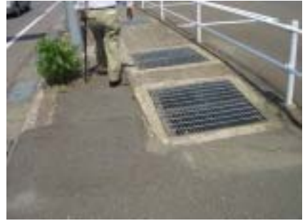
歩道に設置されたグレーチング (あいあいプラザ～西公民館)
