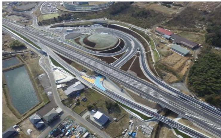
(敦賀南スマートインターチェンジの整備)
