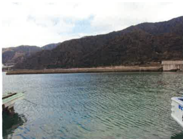
防波堤の全景（港内側より）
