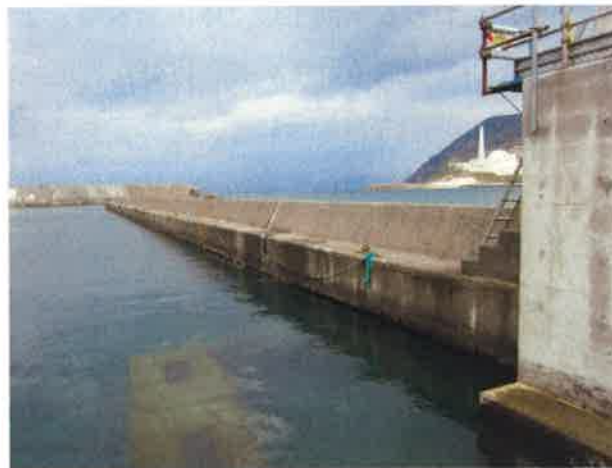
防波堤の全景（砂浜側より）
