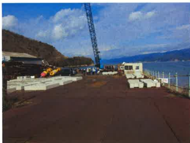
ブロック製作ヤード（全景）
