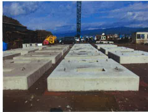
根固めブロック（製作状況）
