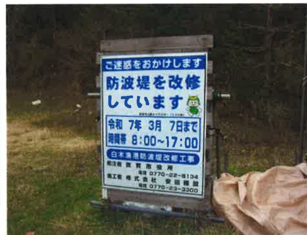
工事案内板（掲示状況）
