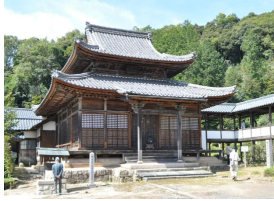
国指定重要文化財(建造物) 西福寺阿弥陀堂
