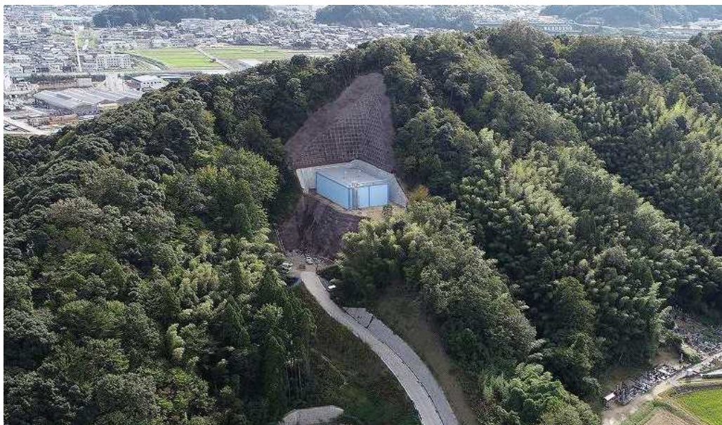
図 5-2 耐震化工事が完了した木崎配水池
