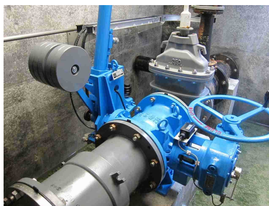
図 3-10 緊急遮断弁
