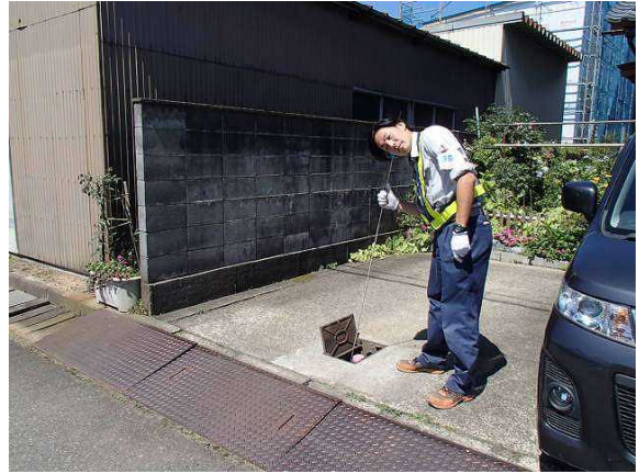
図 3-21 漏水調査
