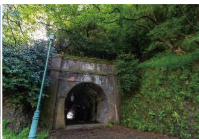
敦賀市と南越前町に跨る鉄道遺構群 旧北陸線トンネル群
