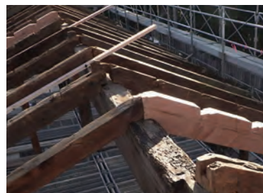
新旧材を含む登り梁の組み上げ
