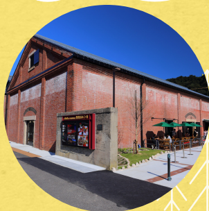
敦賀赤レンガ倉庫
