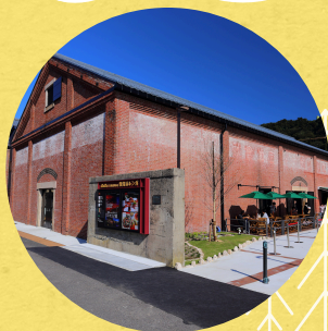
敦賀赤レンガ倉庫
