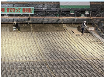
屋根瓦を降ろす
