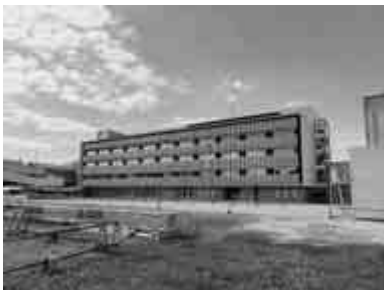
【外構工事が進む市庁舎】
