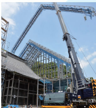
地組みしたトラスを クレーンで吊り上げ
