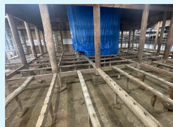
柱と骨組みだけになった床
