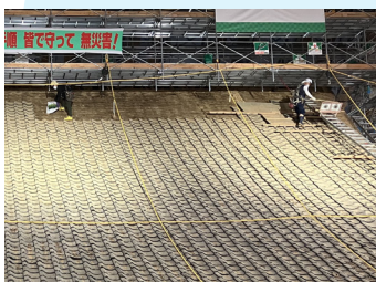
屋根瓦を降ろす
