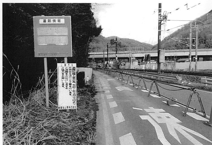
⑩国道 476 号、大蔵付近片側通行規制、状況 ※令和 3 年度 交通センサス、3,375 台 1 日当り (敦賀市道路河川課、提供資料より)
