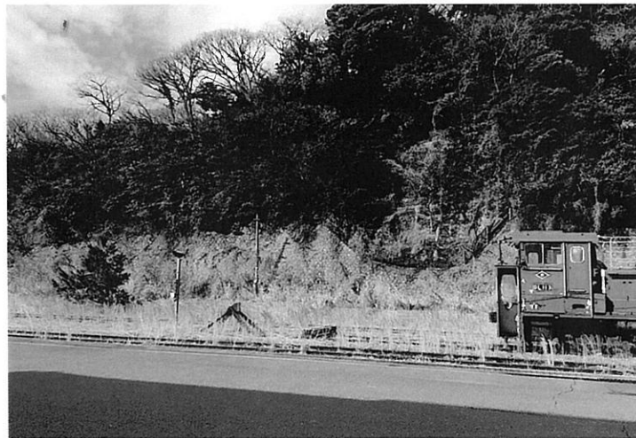
③金ヶ崎、南側斜面部（土砂災害特別警戒区域）、状況 ※一部斜面部に土砂崩れの状況が見られます。
