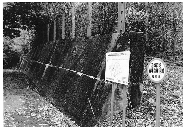
⑤金ヶ崎地区、急傾斜地崩壊危険区域、状況 ※金ヶ崎、金前寺、裏付近擁壁設置現況
