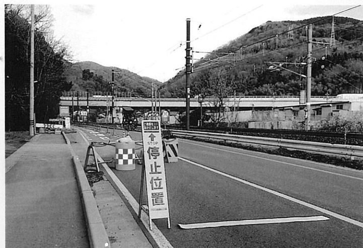
⑨国道 476 号、大蔵付近片側通行規制、状況 ※令和 3 年度 交通センサス、3,375 台 1 日当り (敦賀市道路河川課、提供資料より)
