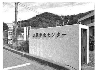
天筒山浄化センター
