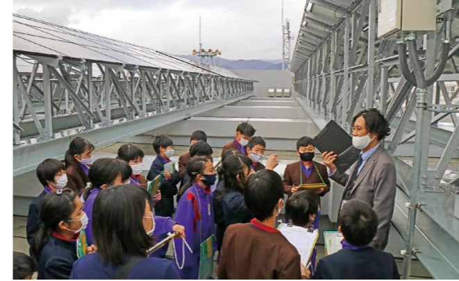
▼屋上に設置された太陽光パネルの前で説明を受ける児童たち
