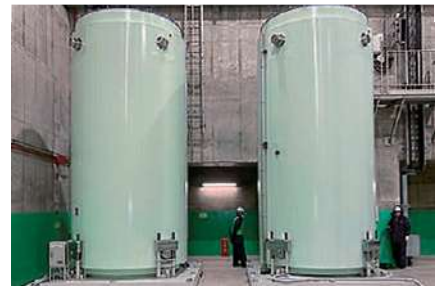
現在貯蔵中の使用済燃料が入った 金属製キャスク 出典：リサイクル燃料貯蔵(株)
