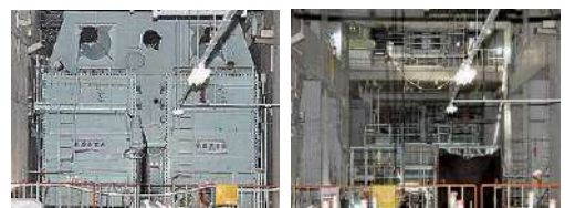
復水器（水室）解体前全景
