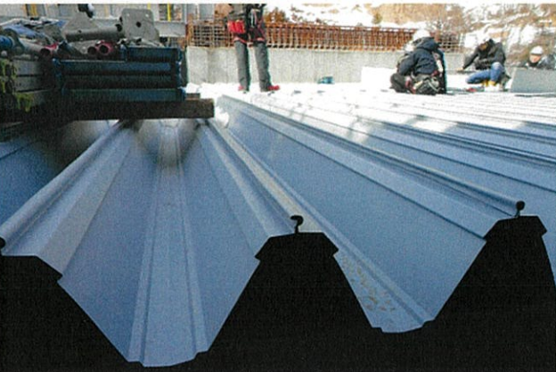
屋根施工状況
