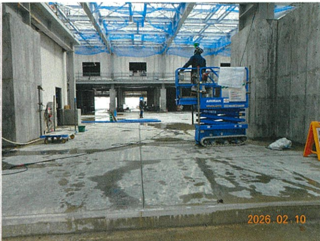
1階プラットフォーム 施工状況
