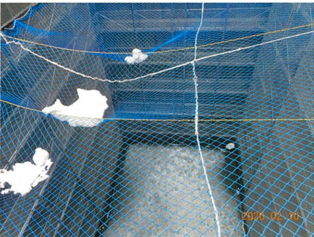
ごみピット施工状況
